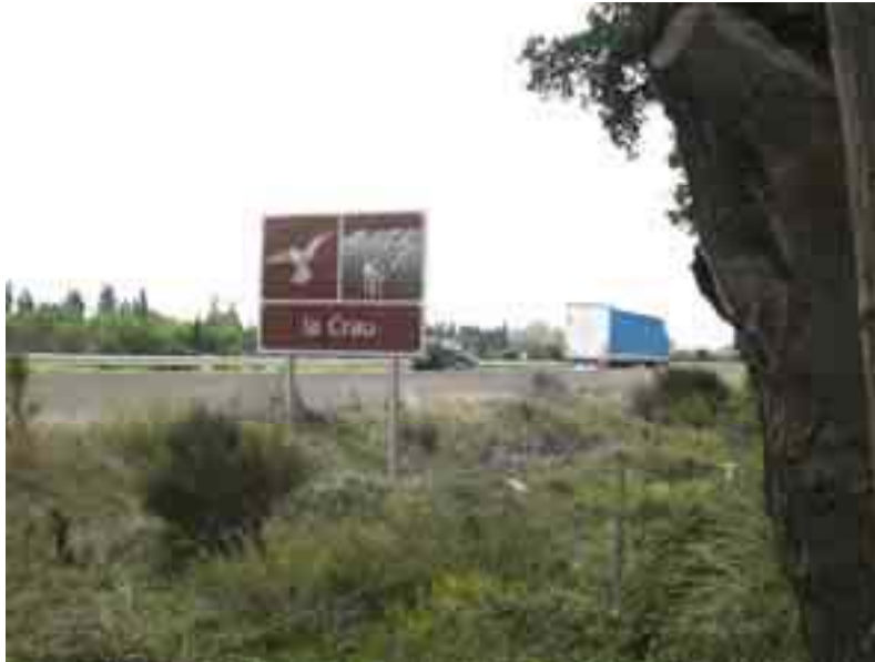
Figure 1 : Autoroute A54, entre Salon et Saint-Martin (photo Vincent, Inra-Ecodéveloppement, septembre 2005)
